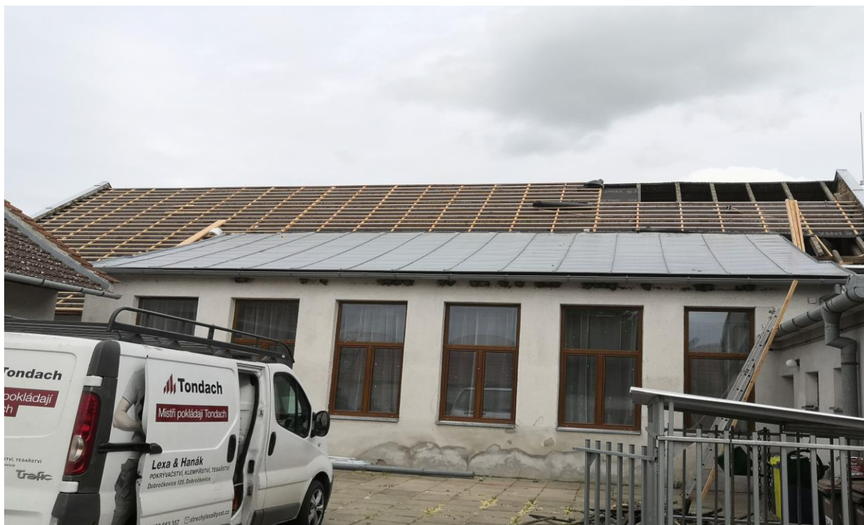
Oprava střechy kulturního domu
