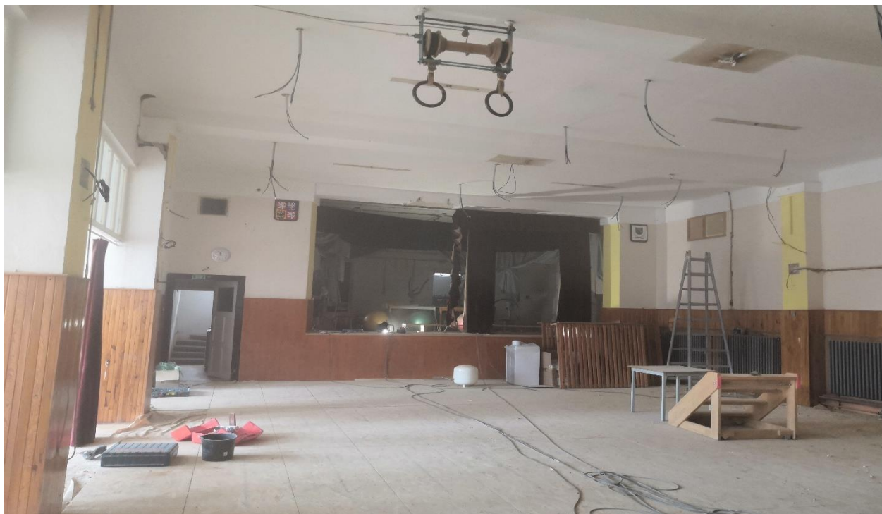
Průběh rekonstrukce sálu KD
