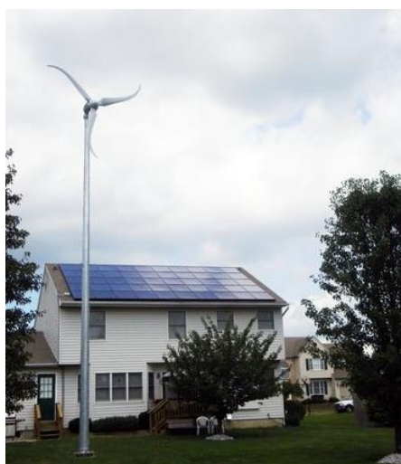
Obrázek 45: V řadě případů VtE přímo na budovách nemá smysl, variantou je menší VtE na stožáru, kombinovaný systém VtE s FVE vč. akumulace. Schéma, vlastní zpracování.
